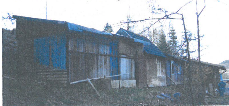
Der Schießstand nach Fertigstellung der Überdachung
